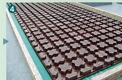
R-パネルの設置
