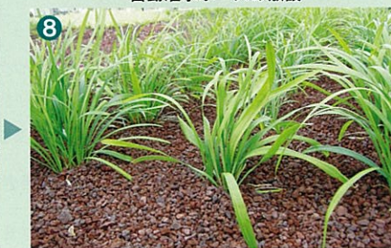
植栽後マルチング材を敷き均して完成
