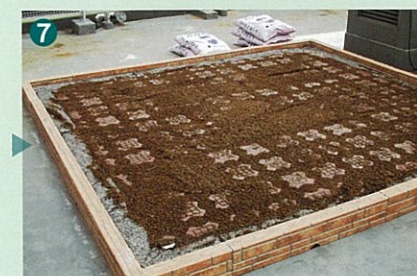
人工土壌の敷き均し
