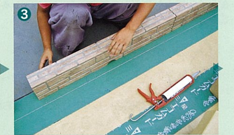
専用見切り材(プライムウォール ボス)の設置
