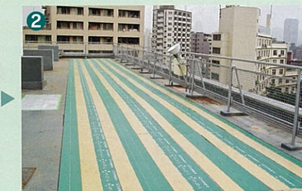
耐根シートの設置
