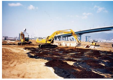
施工中の様子
