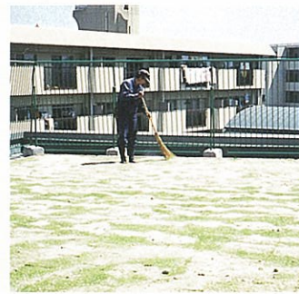
⑦ 目土の散布
