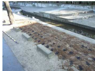
③ルーツリフレッシュを詰めた後の穴。上に土壌を敷き直せば完成する。
