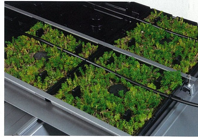
折板屋根に施工した様子。
