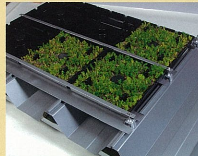
押さえ金具を設置を固定した様子。この後、灌水ホースを設置して完成。
