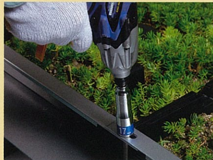
押さえ金具を設置し、ボルトで固定します。
