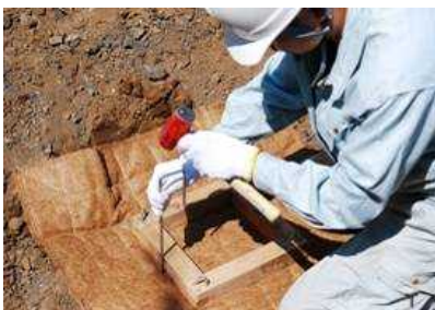
(1) 底面シートを敷き、アンカーピンで固定する
