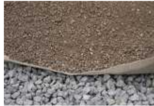
②芝生基盤材の敷設 単粒度碎石（粒の揃った碎石）、透水フィルター、グラスミックスの順番で敷き均します。
