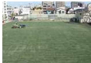
⑥施工完了 最低4週間は立ち入らず養生します。
