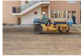
③グラスミックスの転圧 ローラーでしっかりと転圧します。
