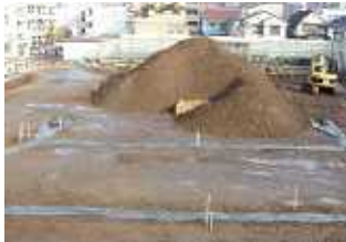
①既存土壌の掘り取り 既存のグラウンドの土を掘り取り、さらに排水のために暗渠を設置します。
