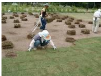
締め固め度 95%以上(最大乾燥密度に対する、現場で測定した乾燥密度の割合)で転圧をしたグラスミックス基盤に、直接芝生を植栽。
