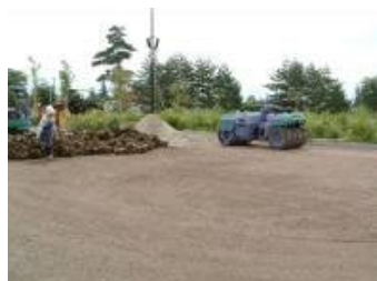
碎石路盤上にグラスミックスを150mm厚で敷均し後、重機で転圧。
