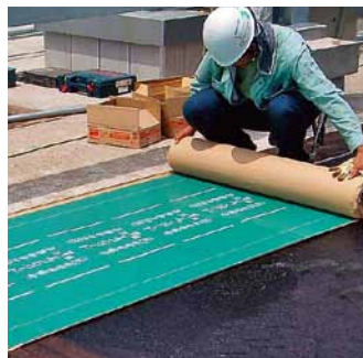
① 自着型耐根シートの設置
