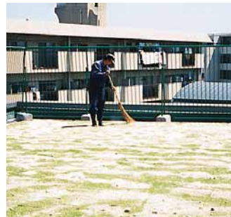
⑦ 目土の散布
