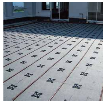
④ 灌水装置の設置
